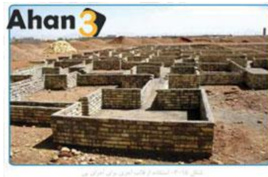
نقش ۳-۱۸- استفاده از قالب آجری برای اجرای بتن
